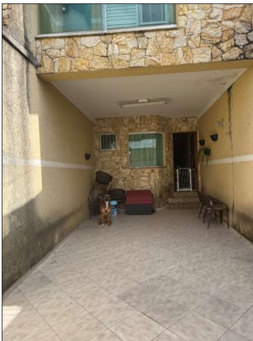
Aspectos gerais da fachada e do abrigo de veículos.
