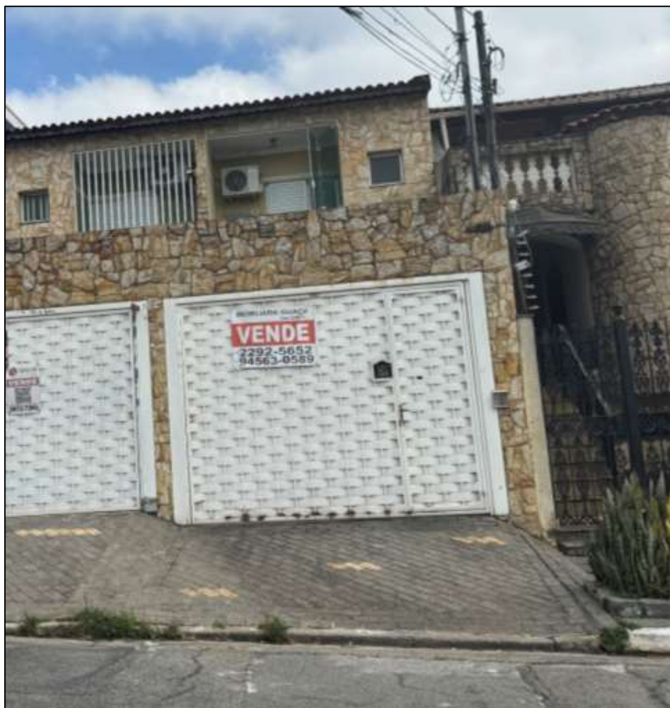
Fachada do imóvel avaliando, Rua Frei Orlando, nº 519 - CASA B.
