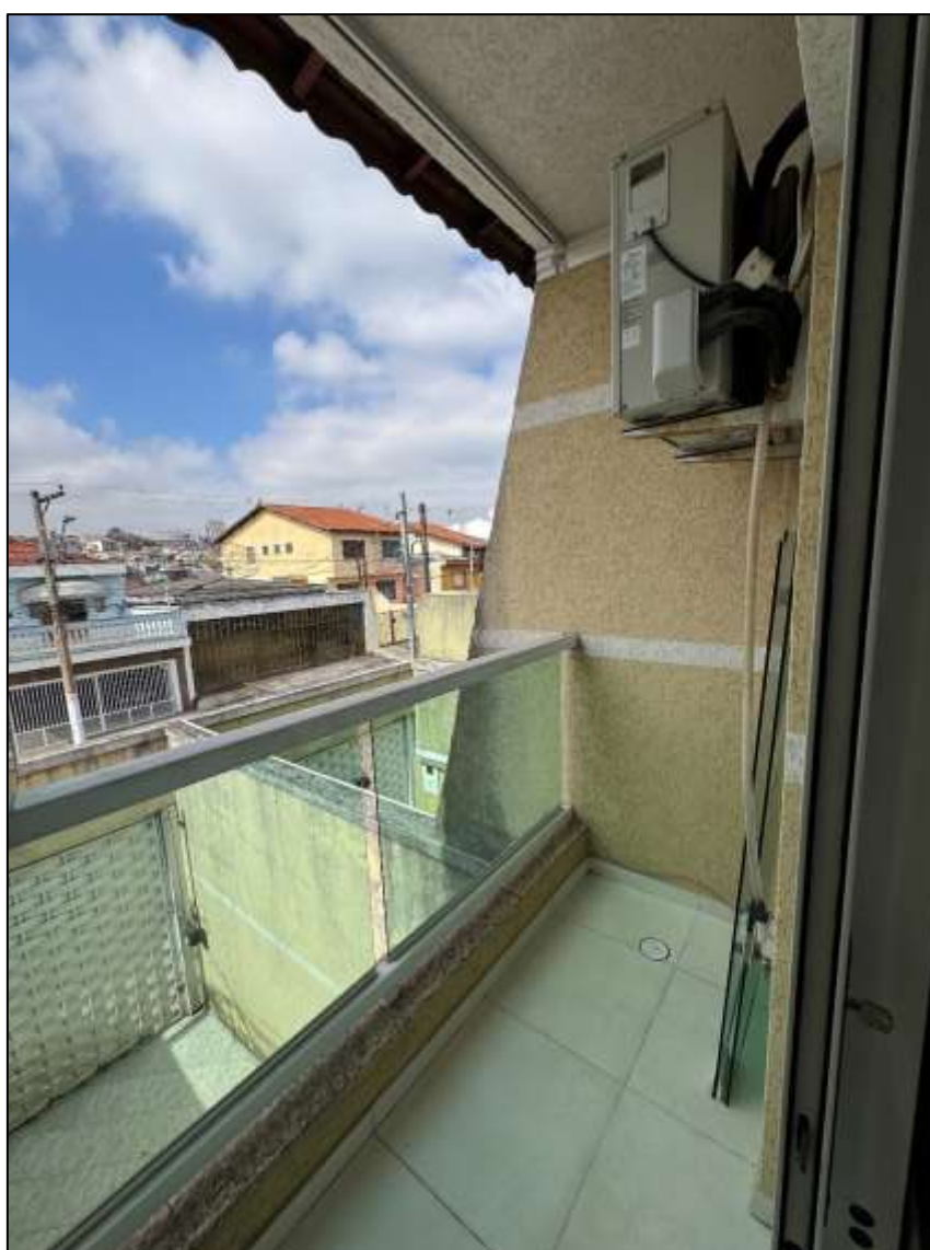
Aspectos gerais da sacada.
