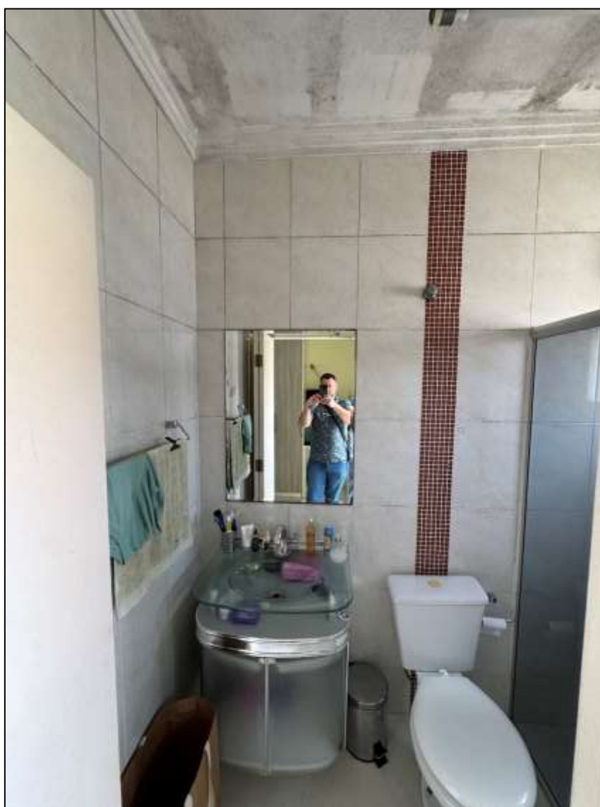
Aspectos gerais do banheiro da suíte.
