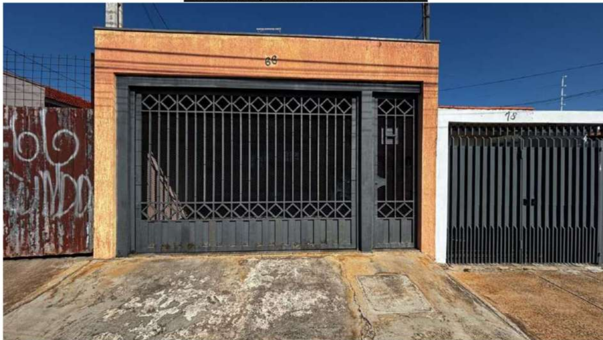
Entrada do imóvel com os portões da garagem e o social;
