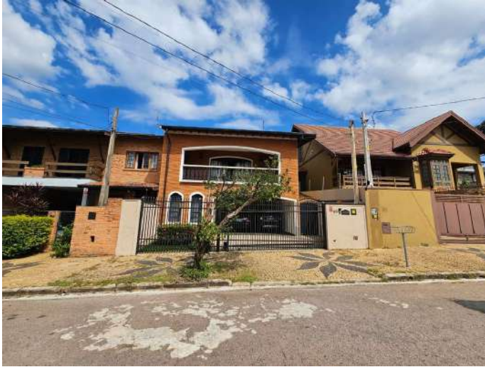
#5 - Imóvel Residencial Fachada Nordeste
