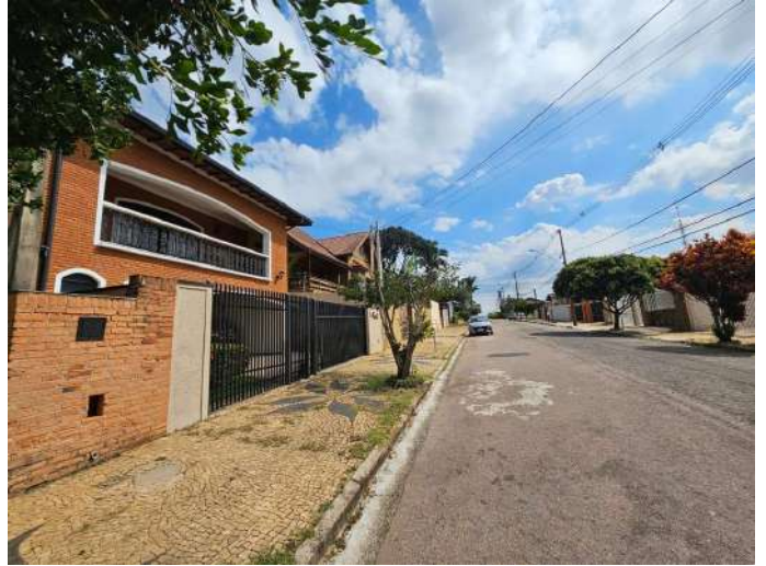
#6 - Imóvel Residencial Fachada Nordeste
