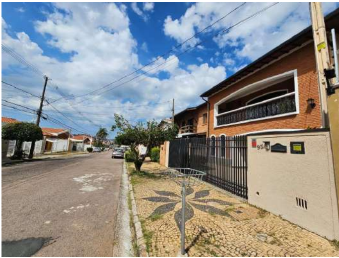
#7 - Imóvel Residencial Fachada Nordeste
